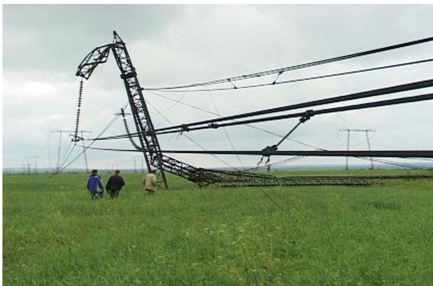
Рис. 2.7. Падение опоры при ураганном ветре
