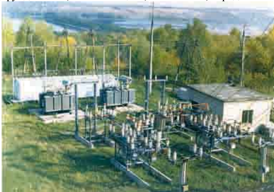
Рис. 2.81. Комплектная трансформаторная подстанция блочная 110 кВ
