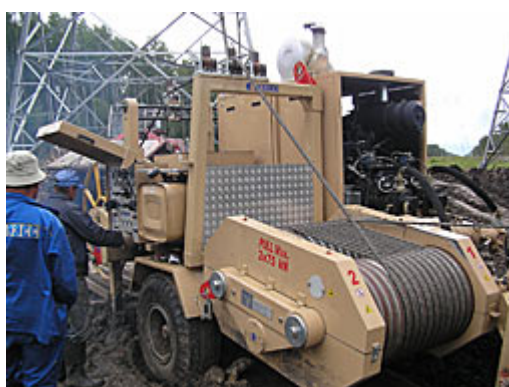
Рис. 2.77. Монтаж изолированных проводов воздушных линий с помощью оборудования фирмы «TESMEC» (Италия)
