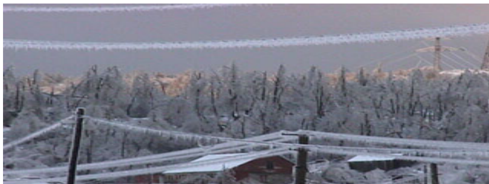
Рис. 2.5. Отложения мокрого снега на проводах
