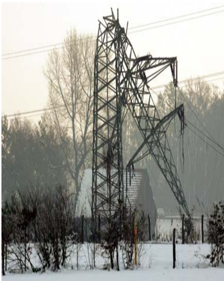
Рис. 2.4. Поломка опоры под действием гололеда и ветра
