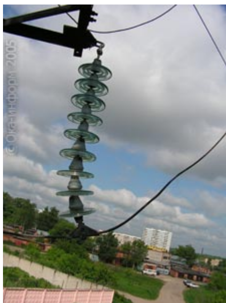
Рис. 2.23. Гирлянда изоляторов
