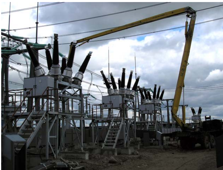
Рис. 2.87. Монтаж элегазового выключателя
