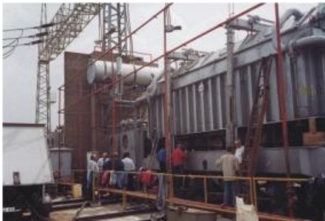
Рис. 2.84. Монтаж силового трансформатора
